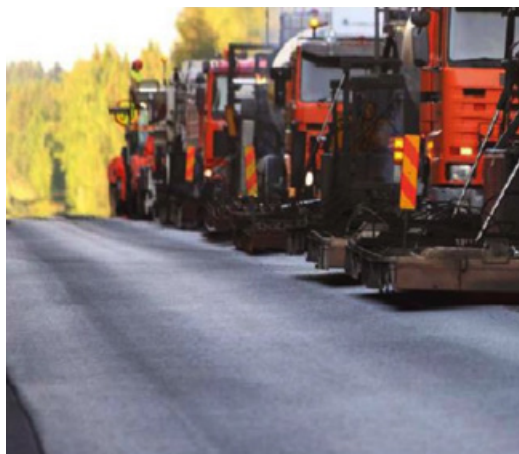
Asfaltkatte kuumtaastamise masinakomplekt
