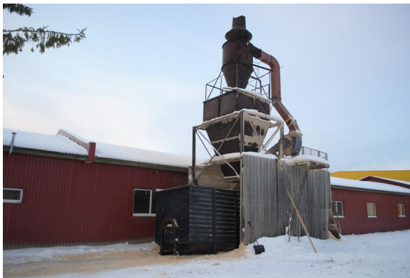
Vana saepuru eemaldamise süsteem, mille ventilaator viis sooja õhu tootmishoonest välja. Fotod: A. Jalander Eesti OÜ
