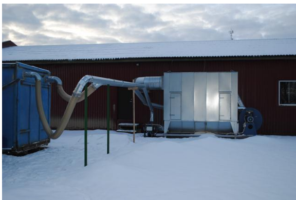
Uut saepuru eemaldamise süsteemi on ohutum hooldada ning soe õhk suunatakse tagasi tööruumidesse.
