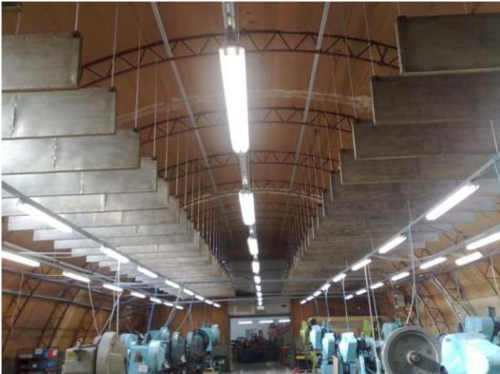
Kolides töö- vahendid uude tööruumi, toodi kaasa ka varasemalt kasutatud müra- tõkke lagi. Foto: Hanza Tarkon
